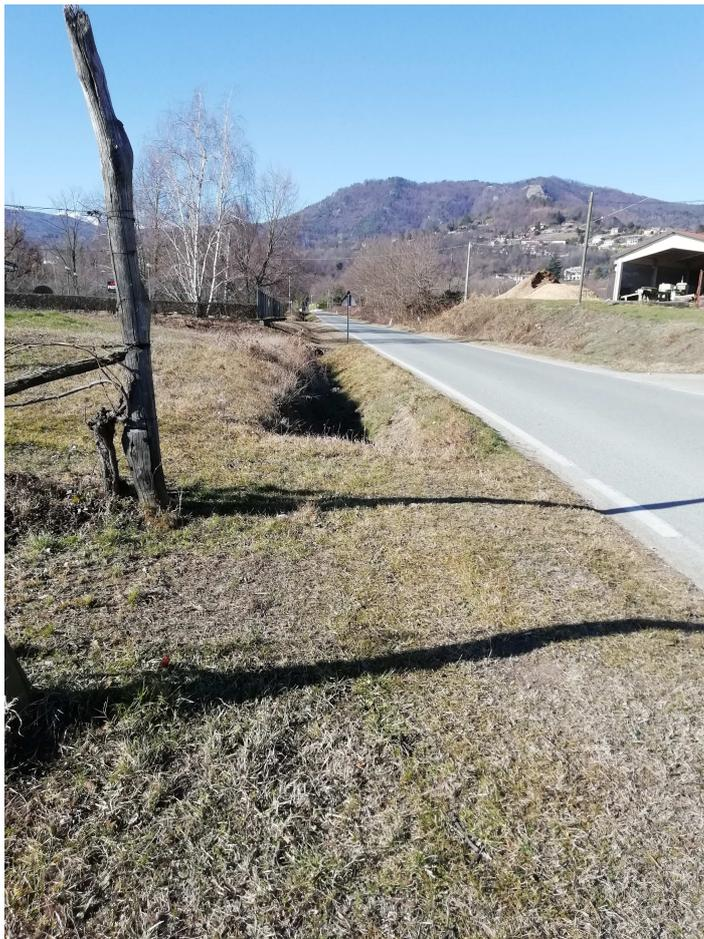
*Figura 15: vista panoramica sul tratto viario interessato dall'allargamento. In primo piano il fosso lungo la corsia sud parzialmente tombato (in primo piano)*
