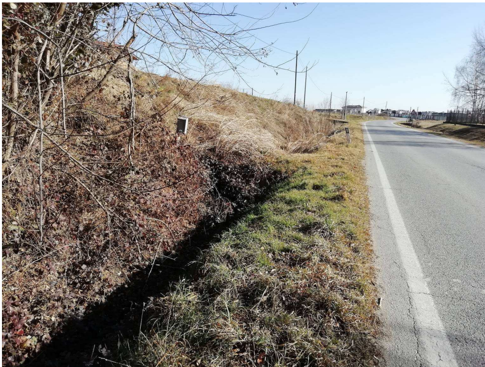
Figura 6 - Vista da valle verso monte del canale di destra.
