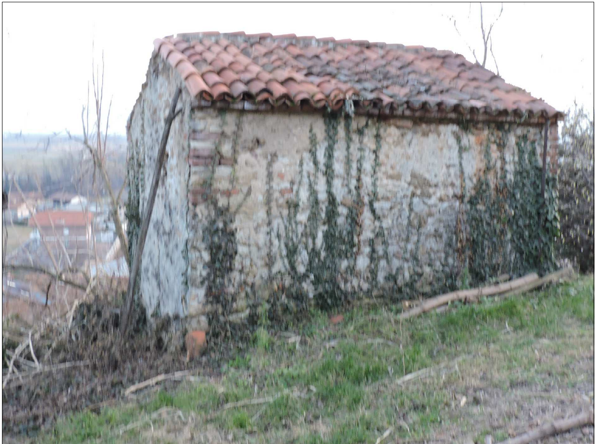
ESTERNO, vista del LATO NORD
