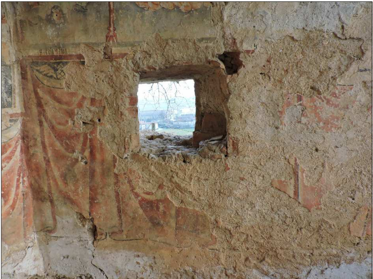
INTERNO, particolare della FINESTRA lato SUD
