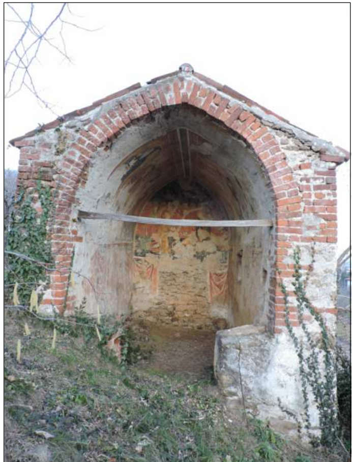
ESTERNO, vista del LATO OVEST
