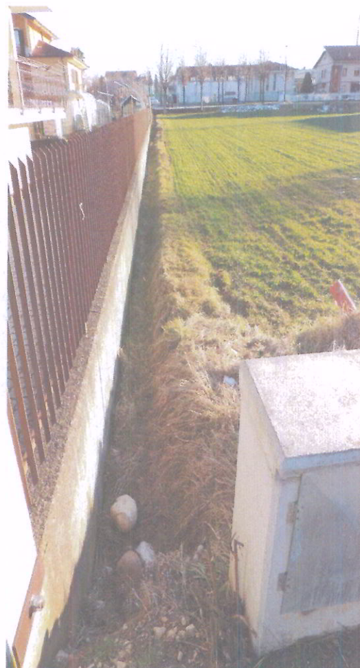
foto 4 - lato Est - recinzione
