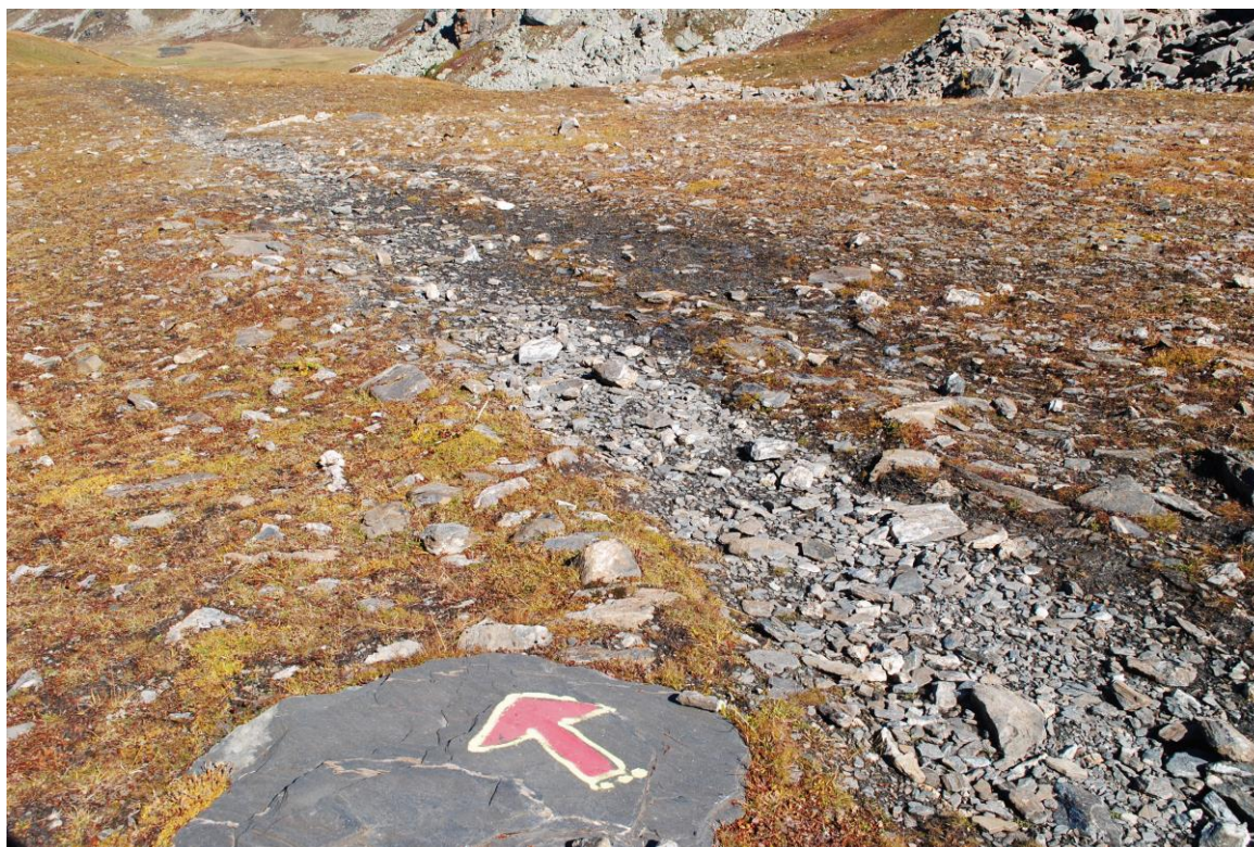
Figura 23 Tratto del sentiero che necessita di segnaletica verticale. . Coordinate UTM – WGS84: 339681 - 4935204
