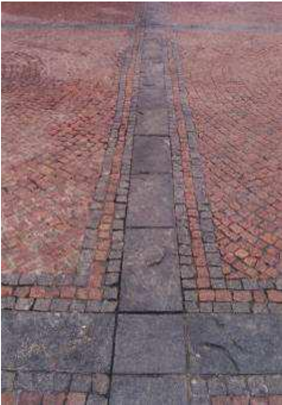
Pavimentazione in cubetti con motivi colorati
