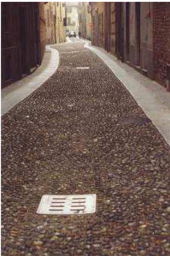
Pavimentazione in ciottolato e lastre di pietra
