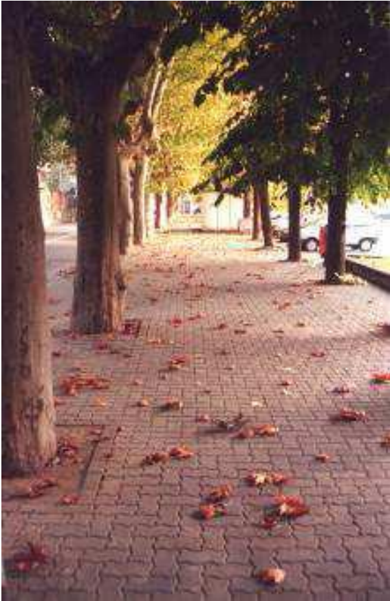
Pavimentazione in autobloccanti
