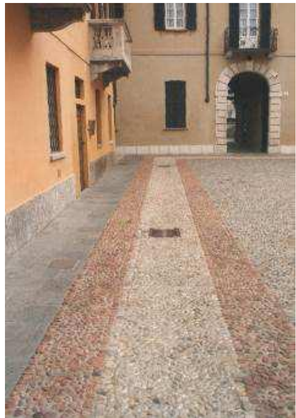
Pavimentazione in ciottoli colorati
