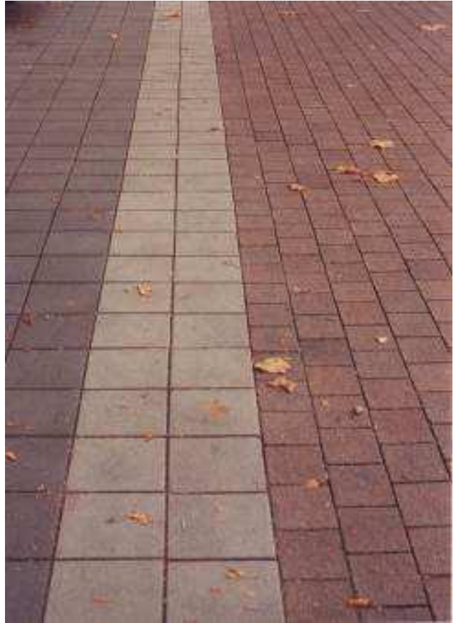
Pavimentazione in autobloccanti quadrati
