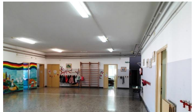
Immagine 13 (Corpi illuminanti zone comuni scuola elementare)
