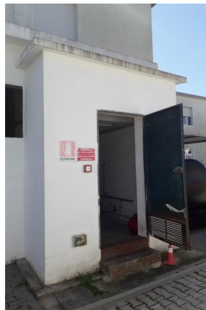
Immagine 19 (Centrale termica scuola elementare)
