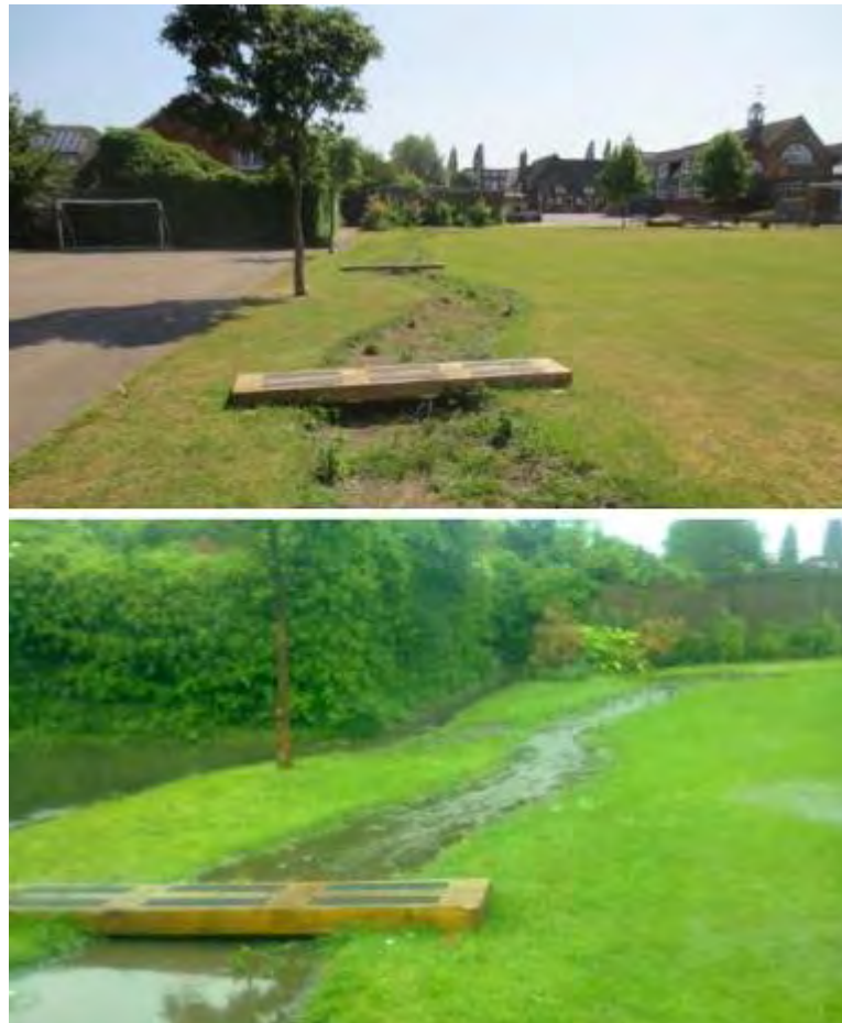
Foto 1: esempio tipologico di area di laminazione con possibilità di utilizzo in condizioni ordinarie (fonte: Manuale di "Gestione sostenibile delle acque urbane" Regione Lombardia/ERSAF)
