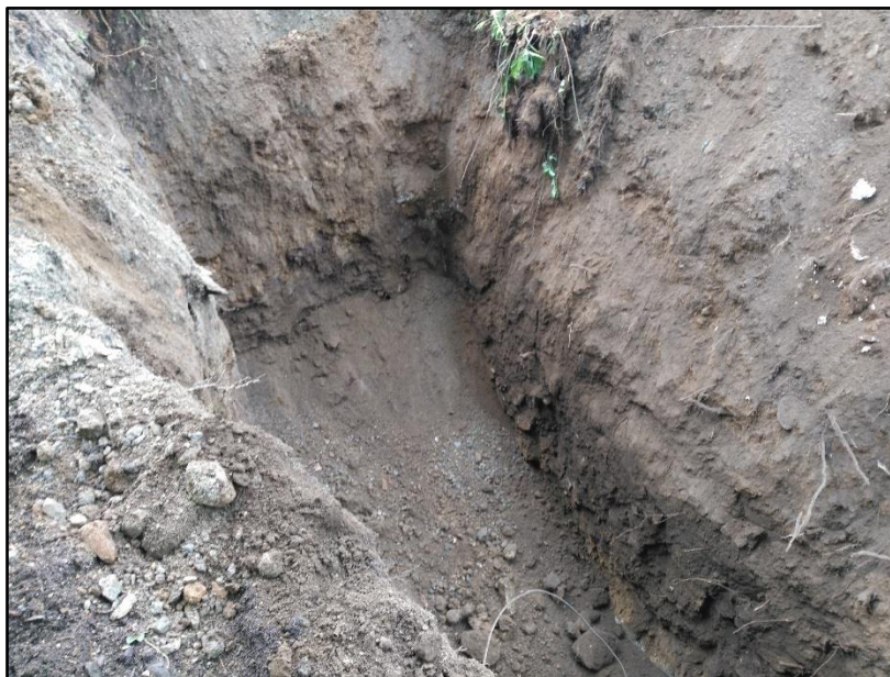
Foto 8: Trincea esplorativa T8
