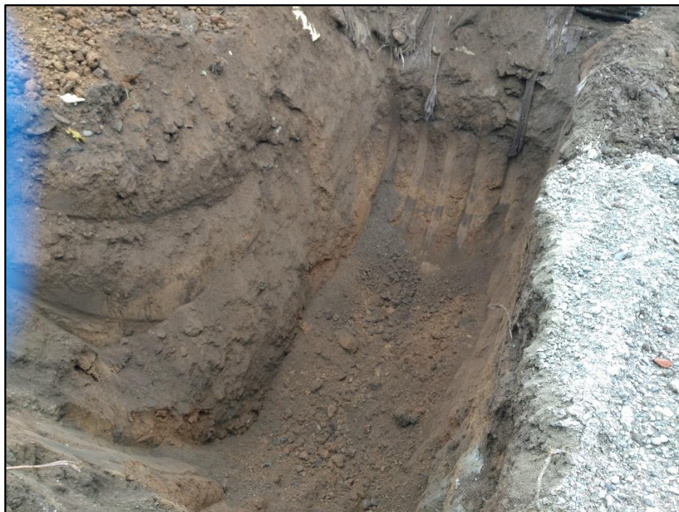
Foto 3: Trincea esplorativa T3
