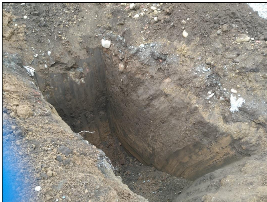
Foto 2: Trincea esplorativa T2
