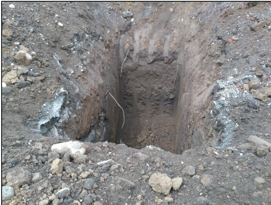
Foto 4: Trincea esplorativa T4
