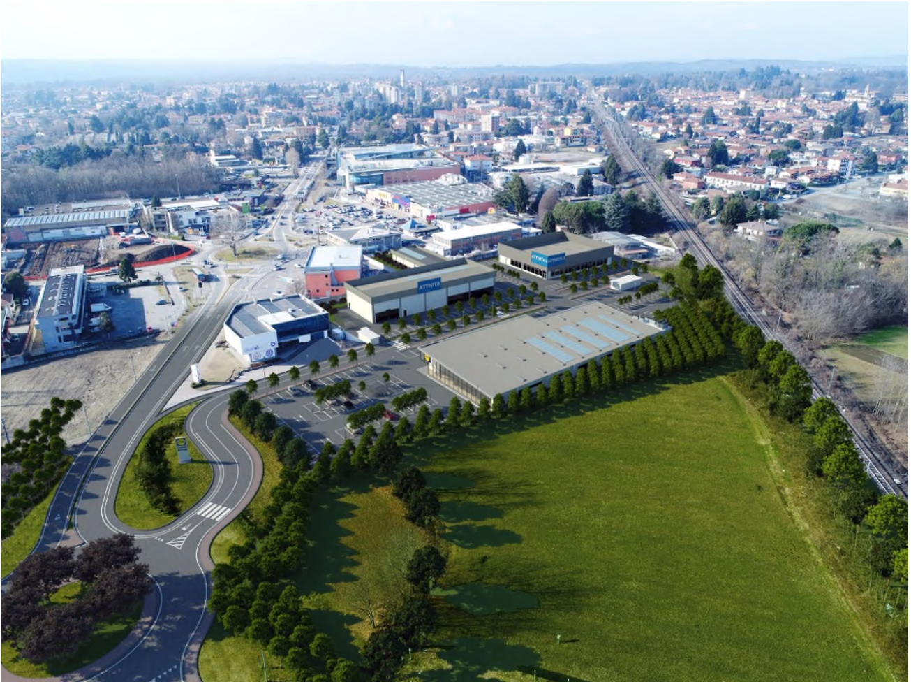
Foto inserimento. Vista OVEST
