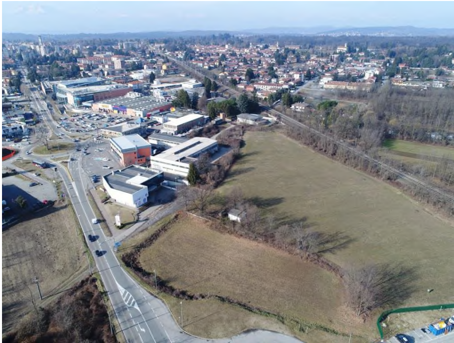
Presa fotografiche aerea: da Sud-EST
