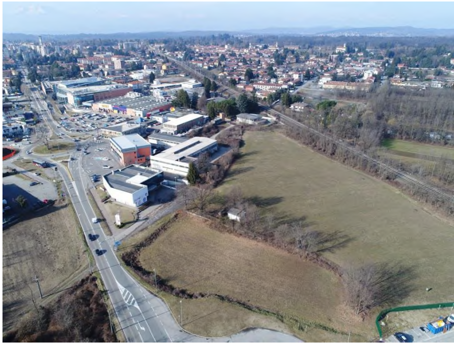
Presa fotografiche aerea: da Sud-EST
