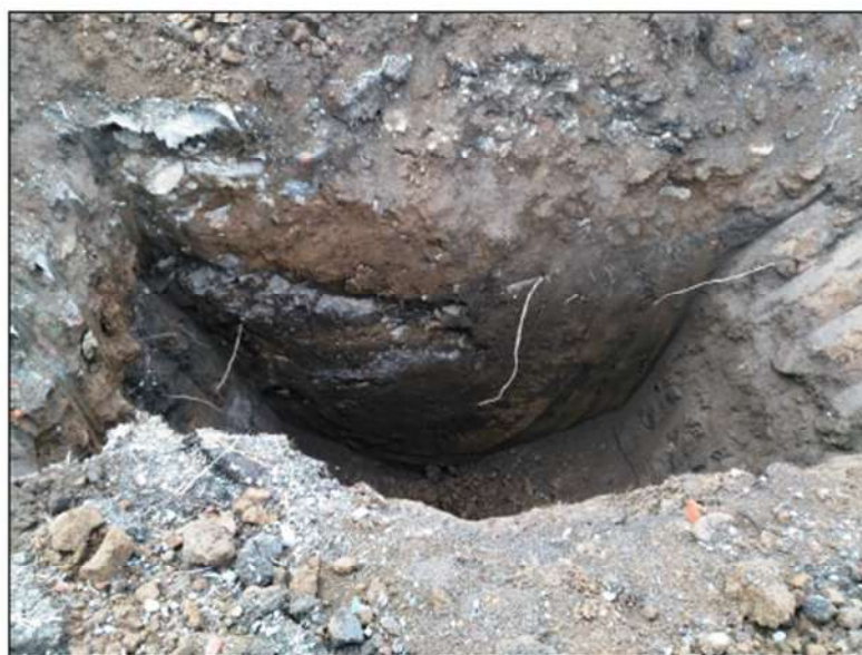
Foto 1: Trincea esplorativa T1
