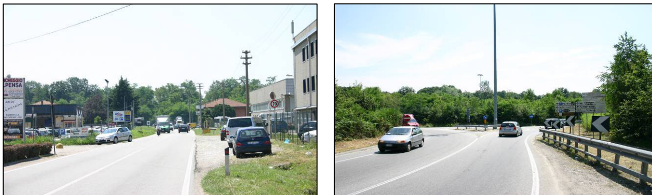
Figura 3: Ingresso Nord-Sud alla SS 336
