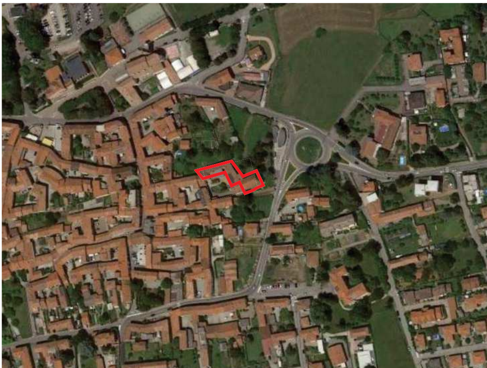
Foto 1 - Inquadramento dell'edificio nel contesto.
