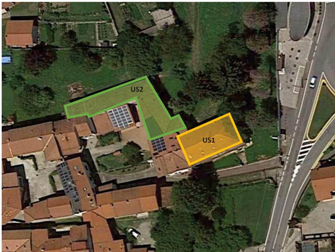
Foto 2 - Suddivisione dell'edificio in Unità Strutturali (US1 in giallo, US2 in verde).
