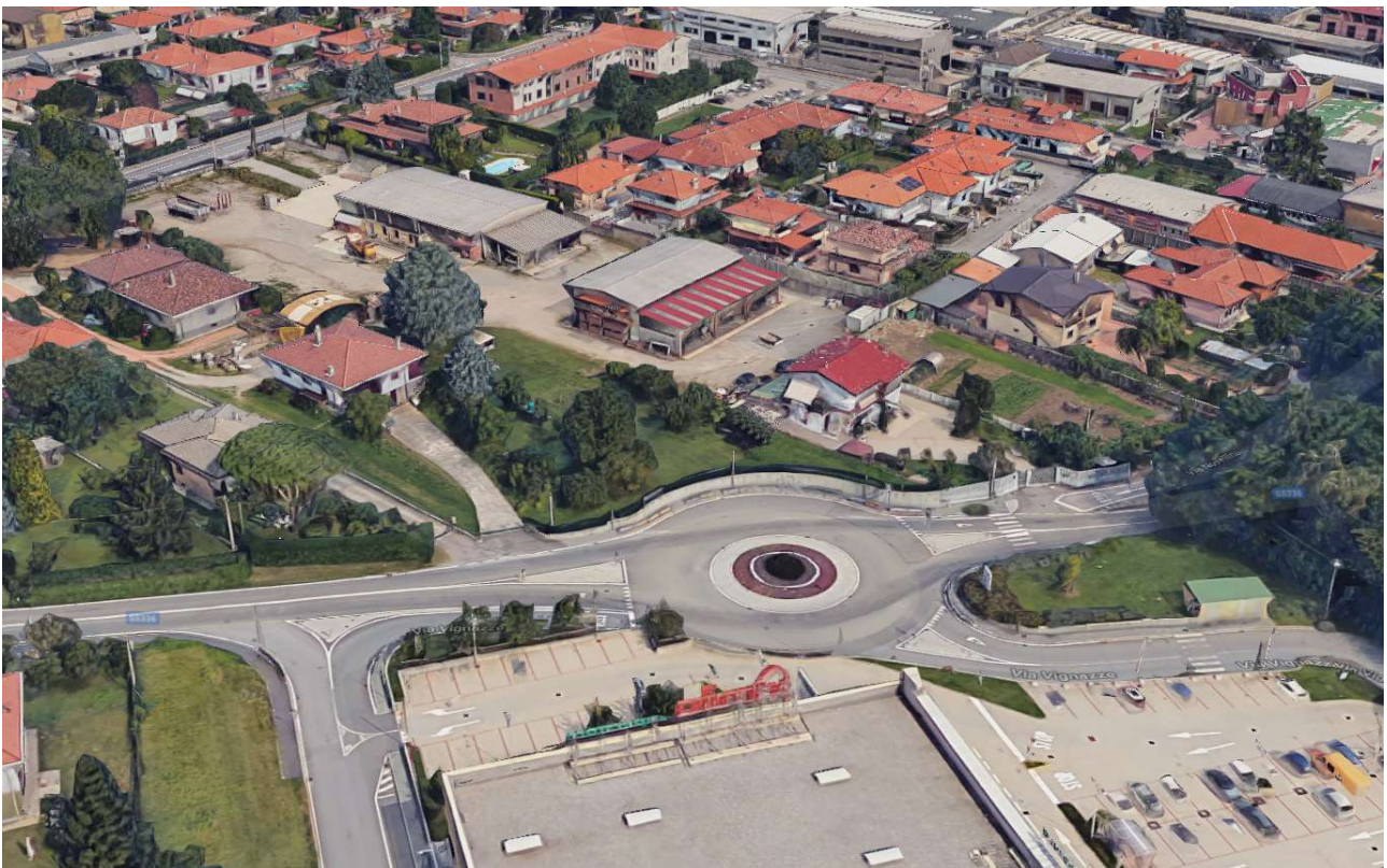
Stato di fatto – Vista Sud Ovest
