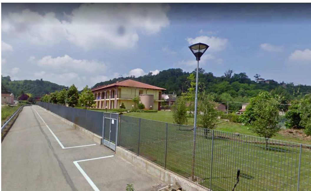
Prospetto retrostante nord-ovest
