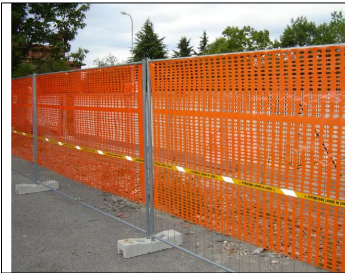
Foto 4.8.1. Esempio recinzione di cantiere
