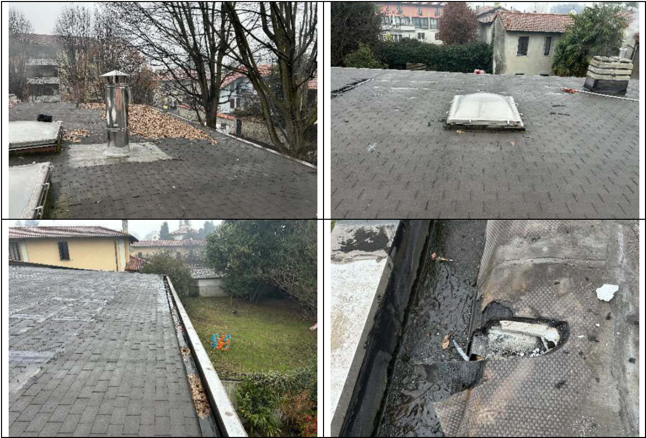
Rilievo fotografico copertura
