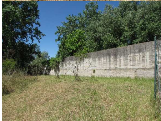
Muro di confine alla base del quale disporre il terreno (sinistra), come in parte già effettuato in passato (destra)
