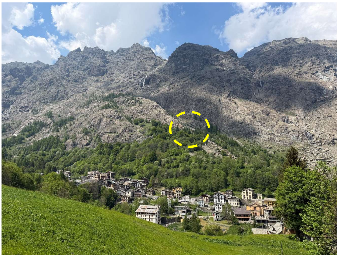
Figura 3.2: Vista da valle del sito valanghivo, all'interno del cerchio giallo viene evidenziato l'argine di deviazione in cls.
