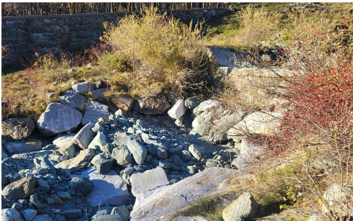
Figura 14 - Scatto fotografico di un punto di erosione a valle di una delle briglie esistenti sul Rio Venaus
