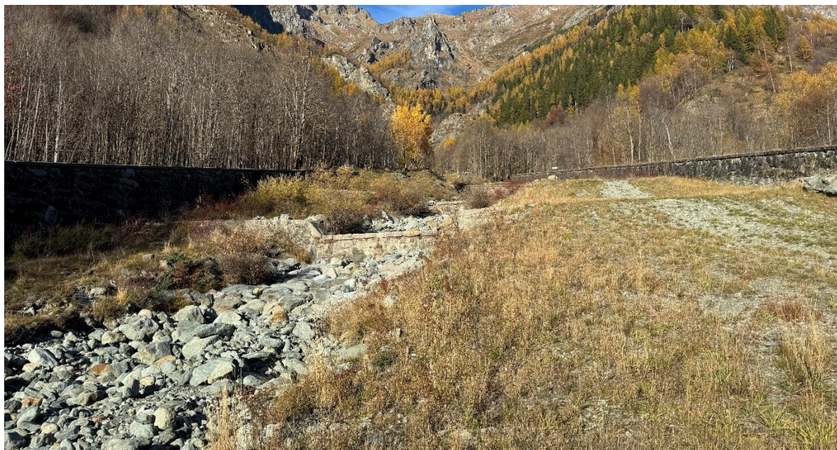
Figura 13 - Scatto fotografico delle briglie esistenti sul Rio Venaus nel tratto oggetto di intervento
