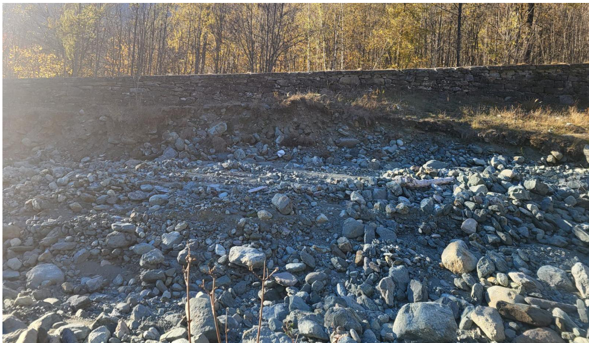
Figura 15 - Scatto fotografico della sponda destra in prossimità del muro in pietra a protezione delle esondazioni
