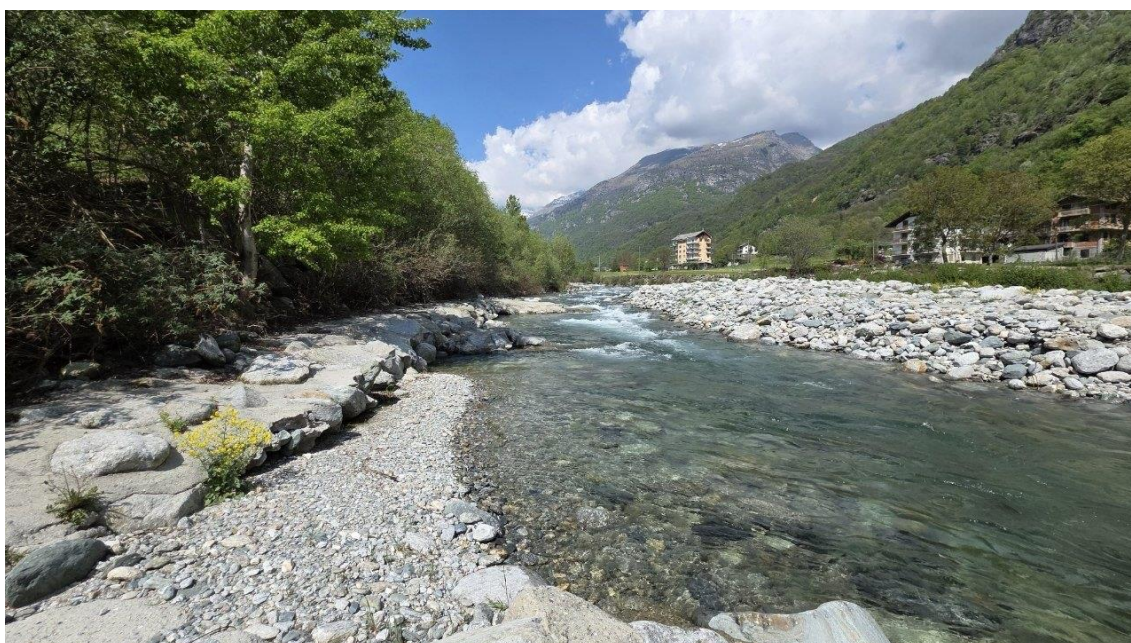
Fig. 2 – immagini del tratto di intervento del Torrente Stura di Val grande.
