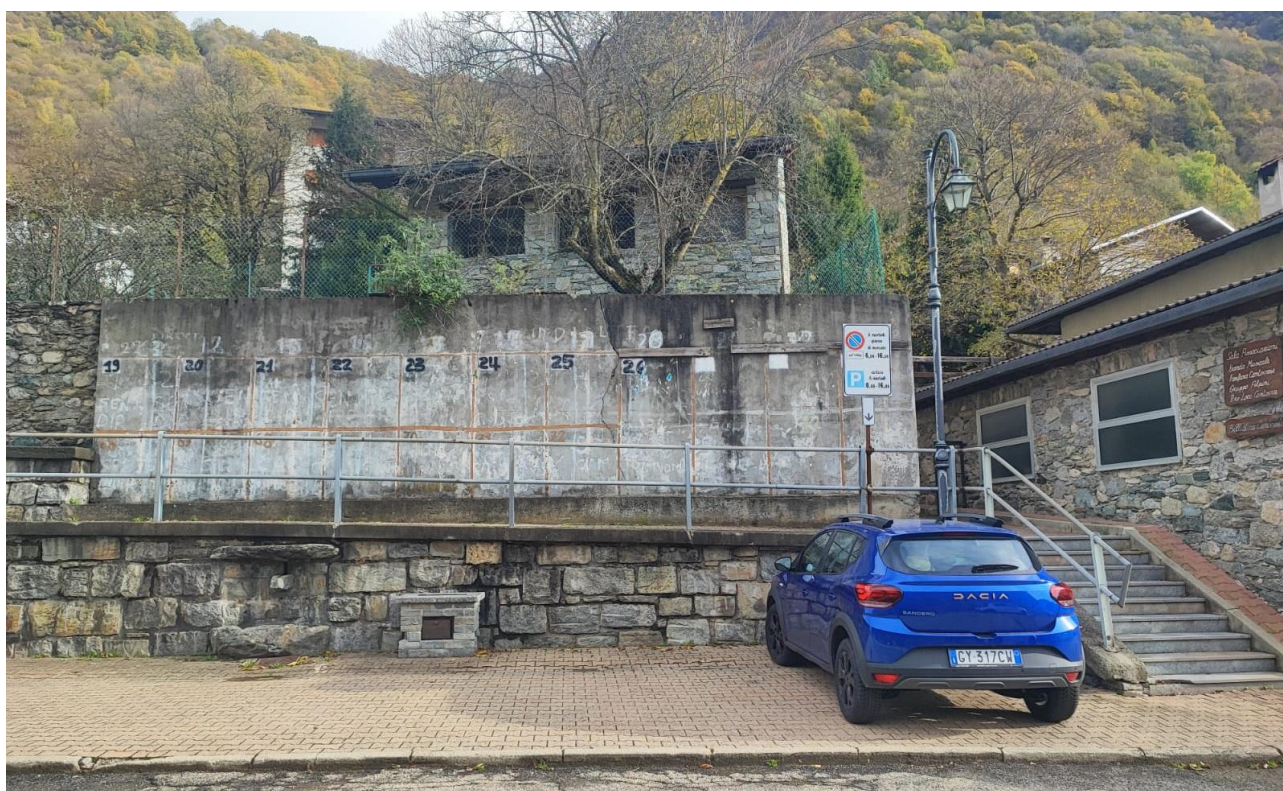
Individuazione del muro di contenimento oggetto di intervento nel suo contesto
