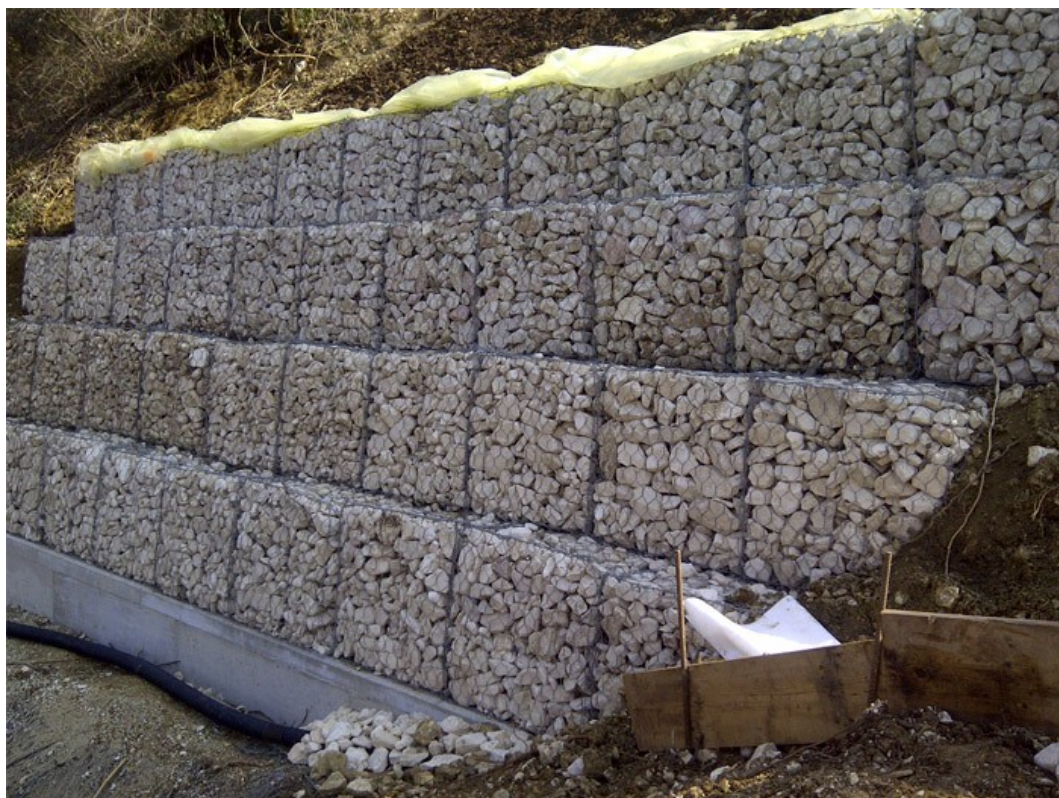
Fotografia 6 – Esempio di gabbionata metallica riempita con pietrame e ciottoli
