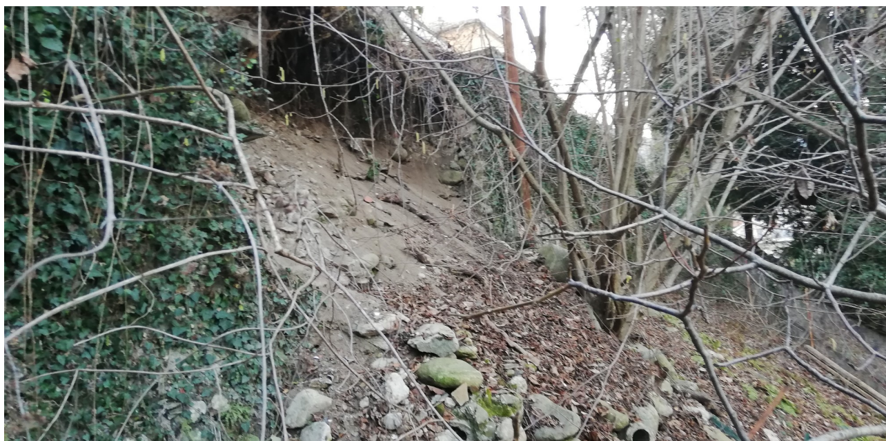
Fotografia 5 – Muro oggetto di intervento
