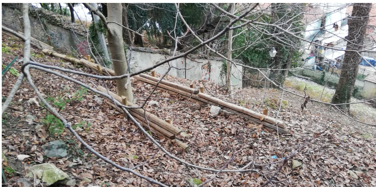
Fotografia 4 – Palizzate provvisorie di protezione in legno
