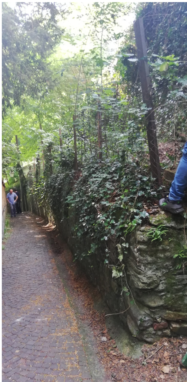
FOTO 7 – Accesso all'area interessata dalla frana alla riva sottostante da vicolo delle Coste II.
