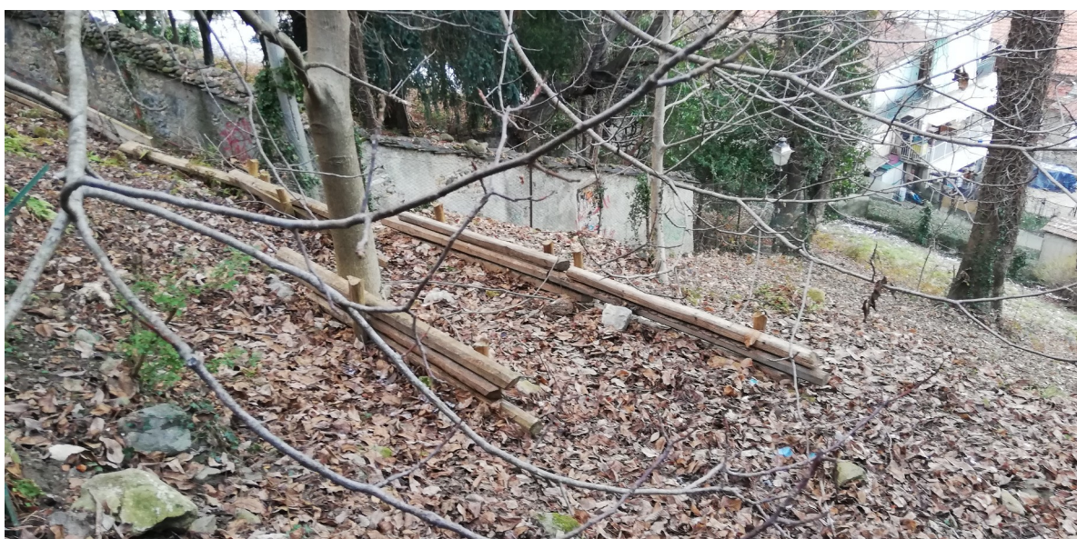
FOTO 6 – Palizzate provvisorie in legno di protezione poste a valle della frana.
