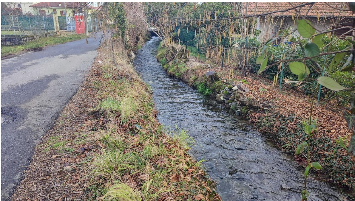
Figura 2 - Vista complessiva, da monte verso valle, del tratto di intervento
