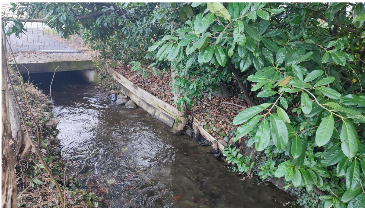
Figura 3 – Vista dalla sponda sinistra, da monte verso valle, dell'alveo del canale nel tratto finale di intervento
