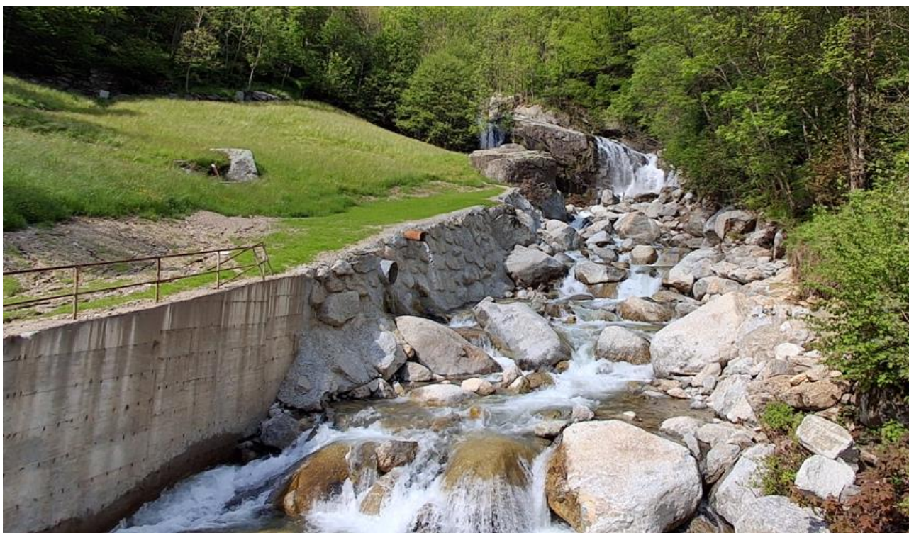
Foto 4 Tratto di muro ricostruito a monte del ponte per la borgata
