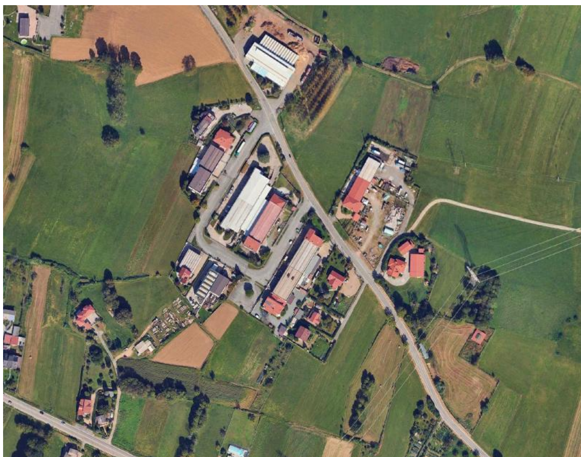
Vista aerea area oggetto della variante parziale
