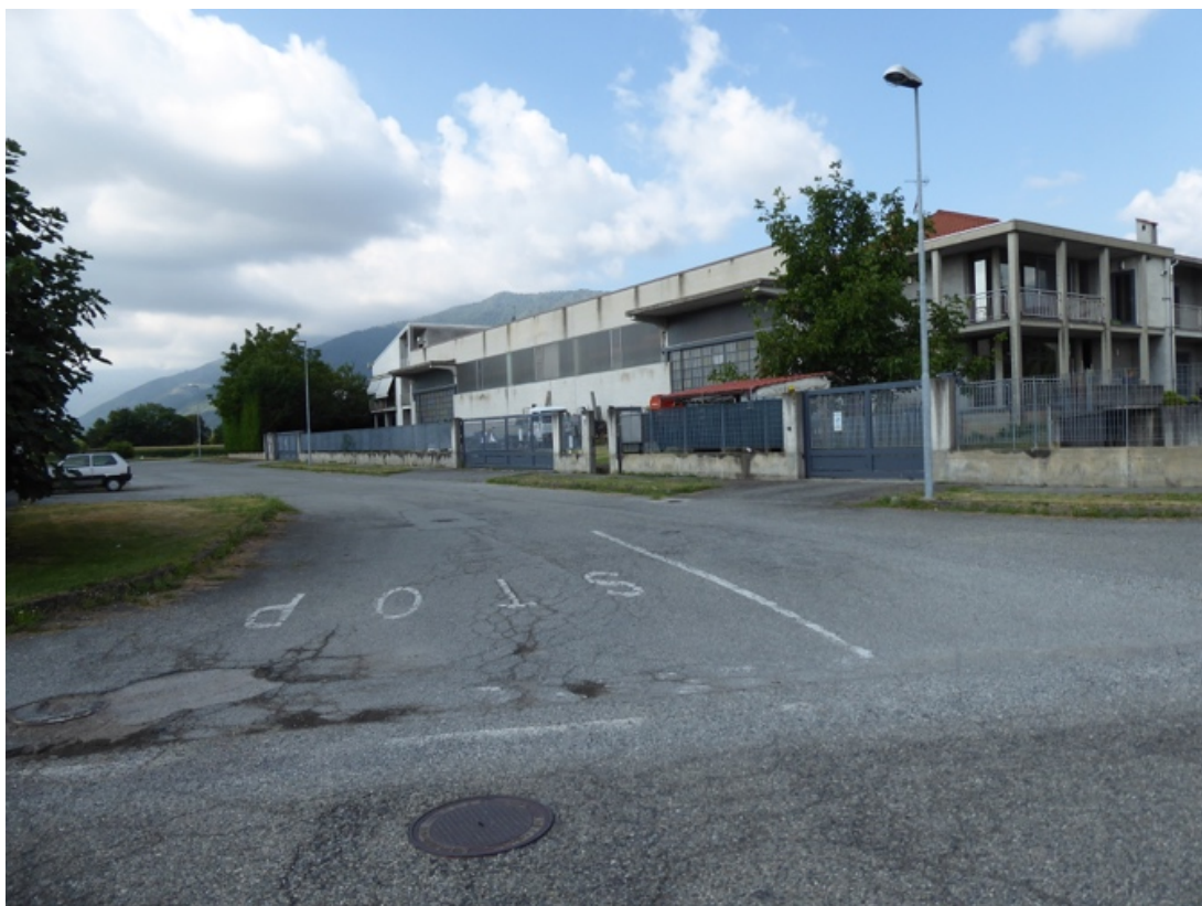
Fotografia n. 3: accesso sud all'area di PEC
