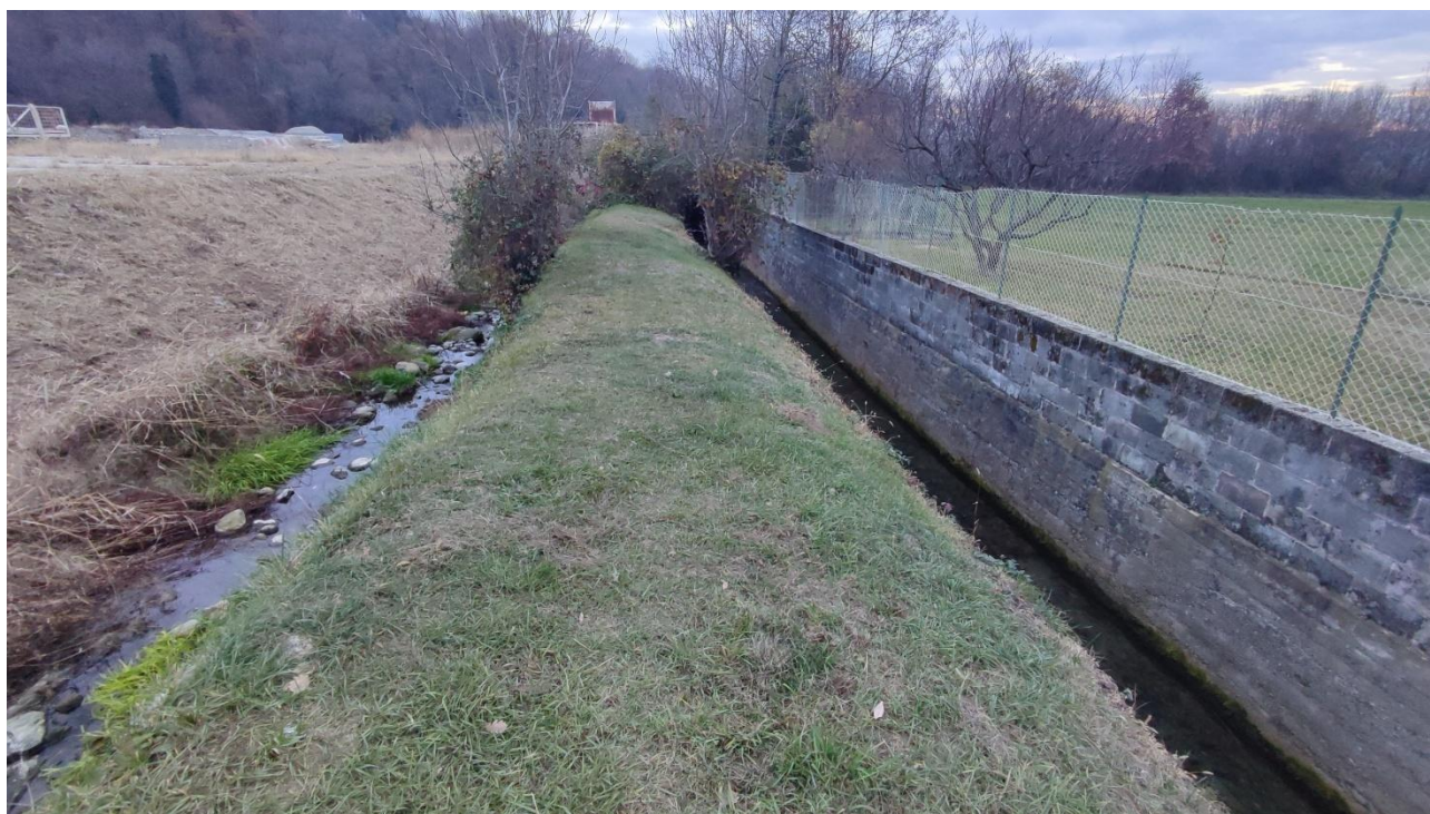
Figura 2 – Configurazione spaziale attuale dei due corpi idrici negli ultimi 50 m, vista da monte verso valle. A sinistra il Rio Canavese e a destra il canale comunale di Balangero.
