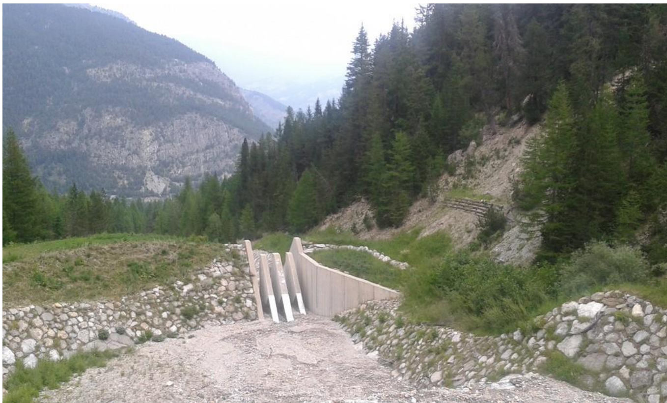
Foto 10 briglia selettiva a chiusura della vasca di deposito sul Rio Gorgia a Bardonecchia
