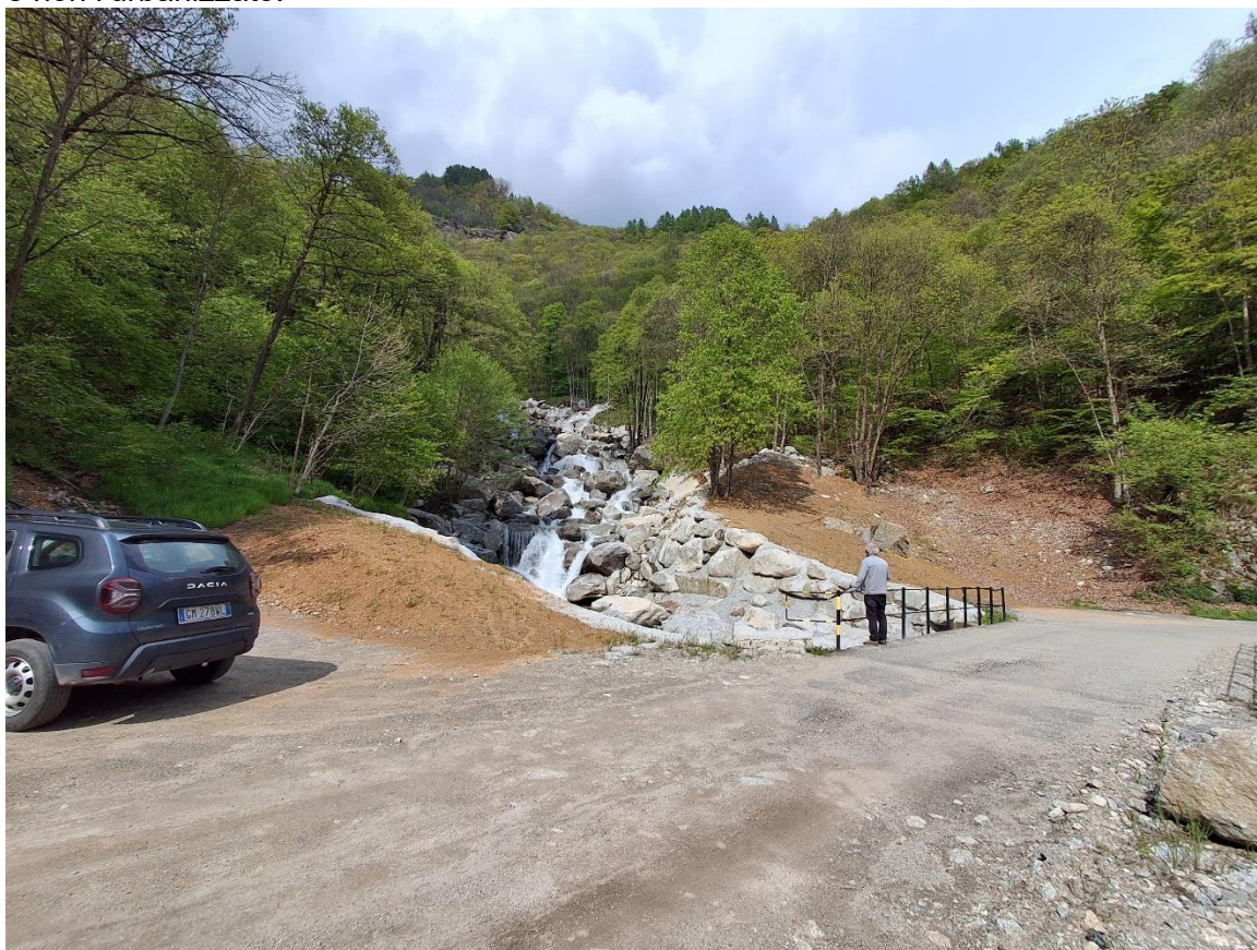
Foto 8 Ponte per Pianardi Balmavenera a monte del quale è prevista una briglia selettiva non coperta dal presente finanziamento. A seguito dell'evento del 2024 erano già stati eseguiti lavori di messa in sicurezza che sono visibili nella foto
