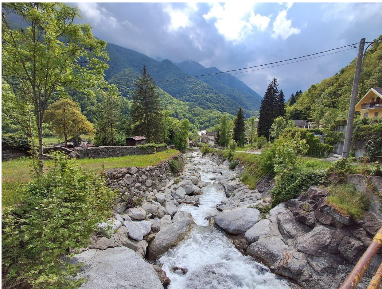
Foto 2 tratto del Vassola oggetto di intervento ove sono presenti le briglie da sistemare
