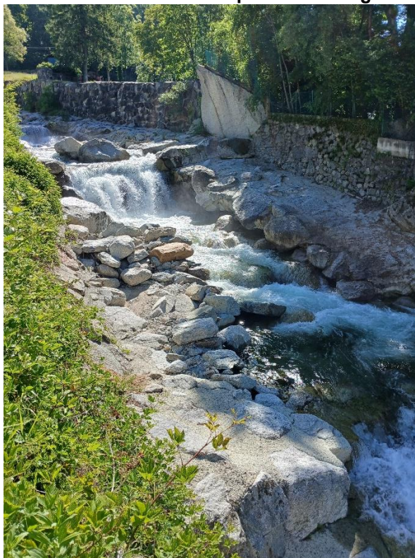
Foto 3 Vassola in ambito urbano, si notino le briglie e le erosioni esistenti
