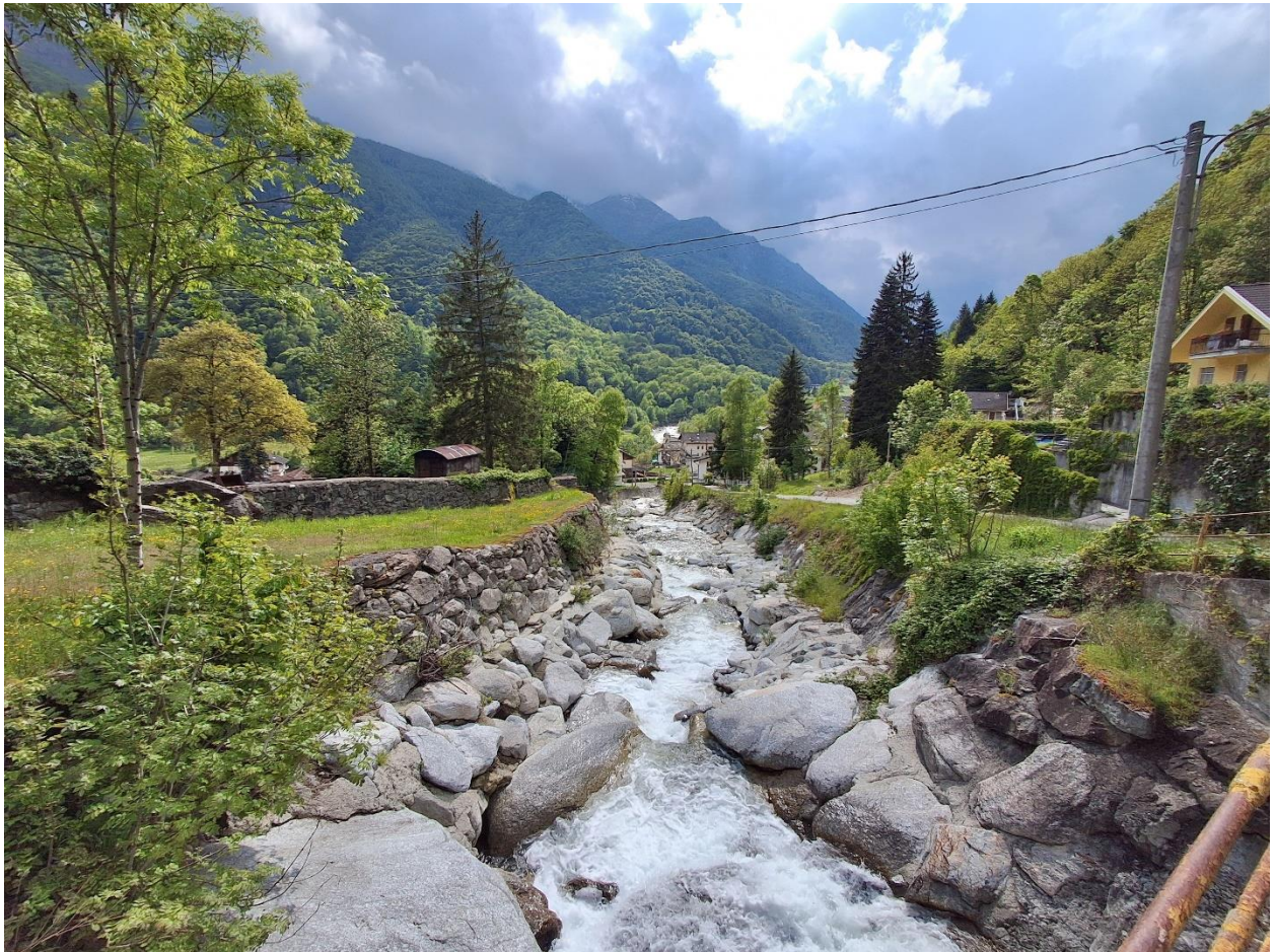
Foto 6 tratto del Vassola oggetto di intervento ove sono presenti le briglie da sistemare
