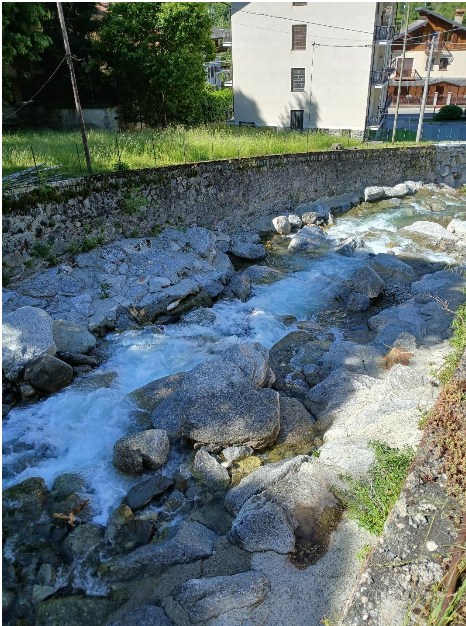
Foto 8 Vassola in ambito urbano, si notino le briglie e le erosioni esistenti
