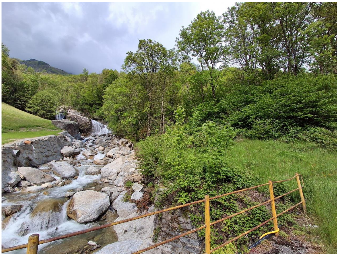
Foto 12 tratto del Vassola a monte del ponte per case Michiardi ove è prevista la briglia selettiva; è inquadrata la sponda sinistra
