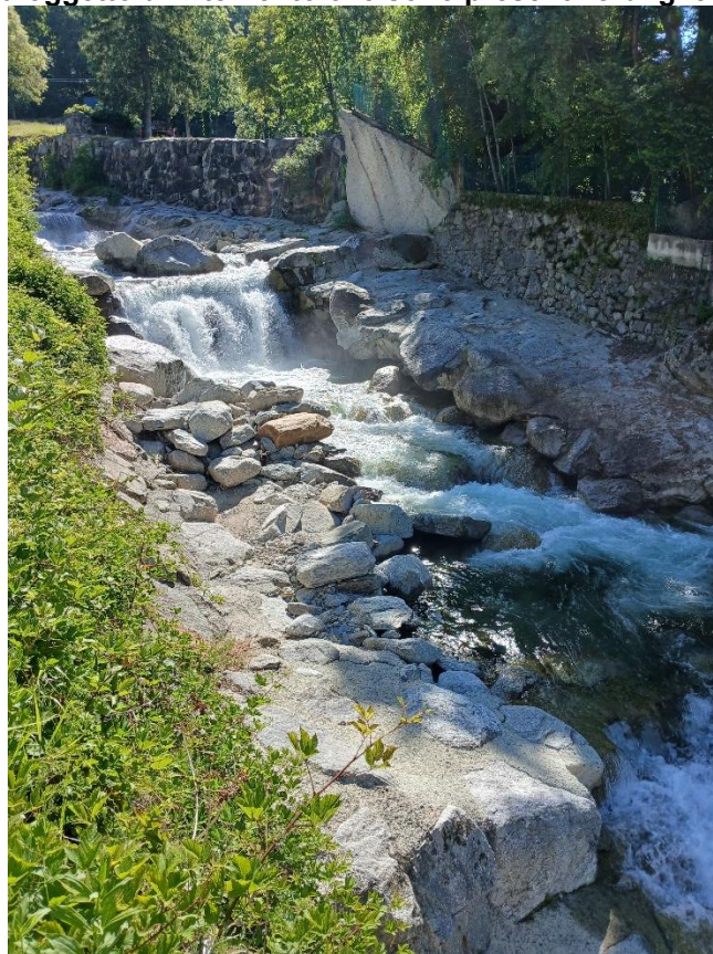
Foto 7 Vassola in ambito urbano, si notino le briglie e le erosioni esistenti
