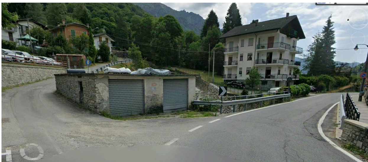
Figura 31 SP33 e Via Case Michiardi da cui si entra in alveo per la realizzazione della pista (fonte Google Earth)
