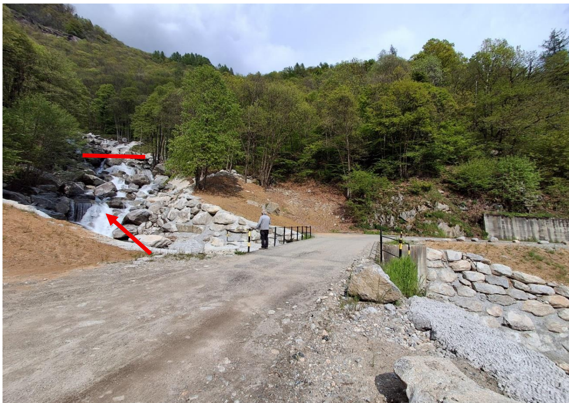
Foto 5 Interventi futuri a monte del ponte della strada per Balmavenera e Pianardi
