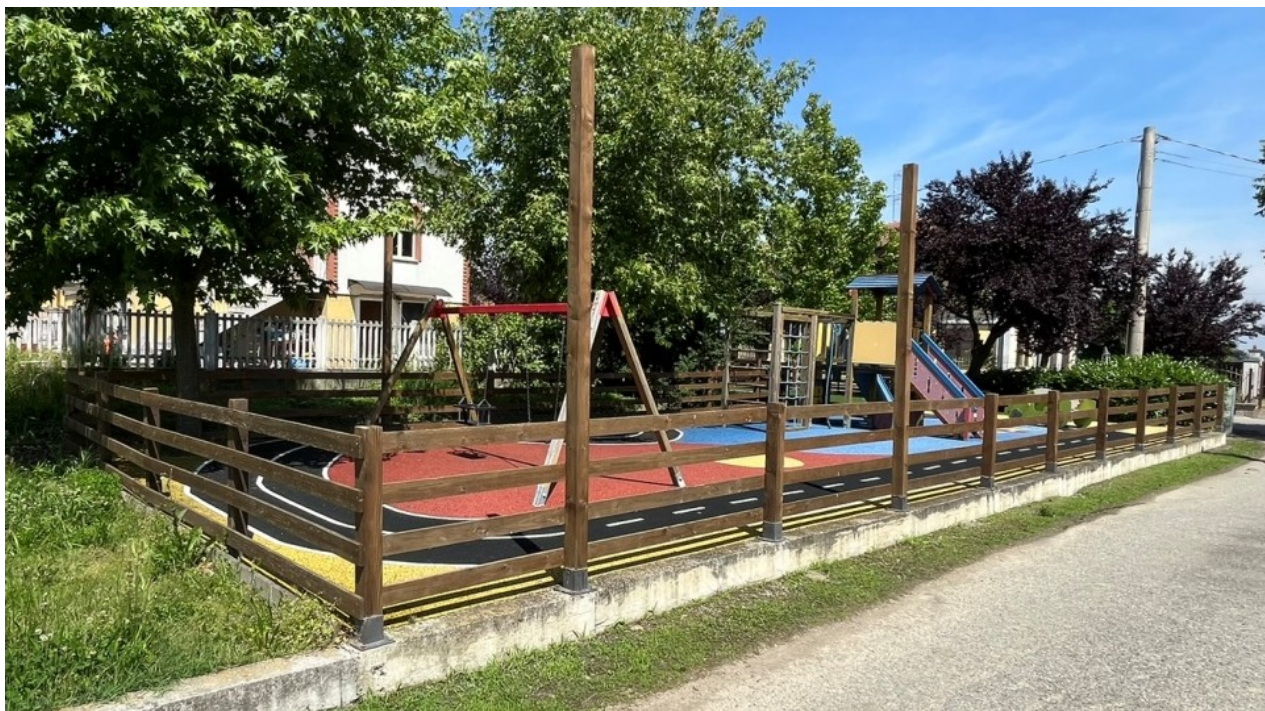
Vista del parco giochi esistente con le attrezzature ludiche oggetto di rimozione e smaltimento
