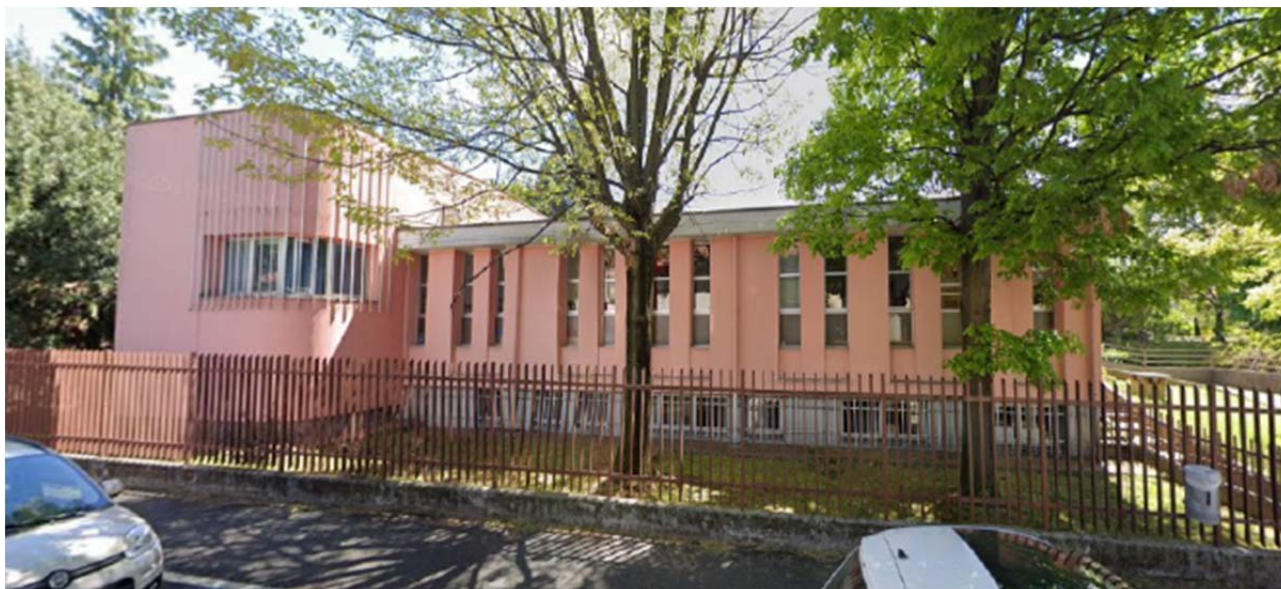
FOTO PROSPETTO NORD-OVEST
