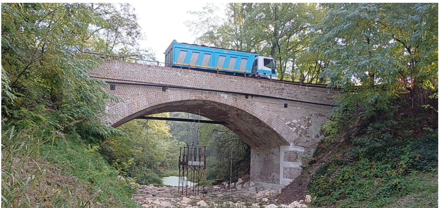
Foto n°1 – Intervento di rinforzo cappa strutturale arco impalcato
