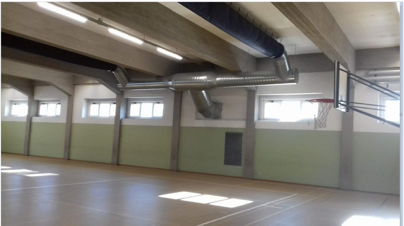
Foto n.3 – Rifacimento impiantistica meccanica
