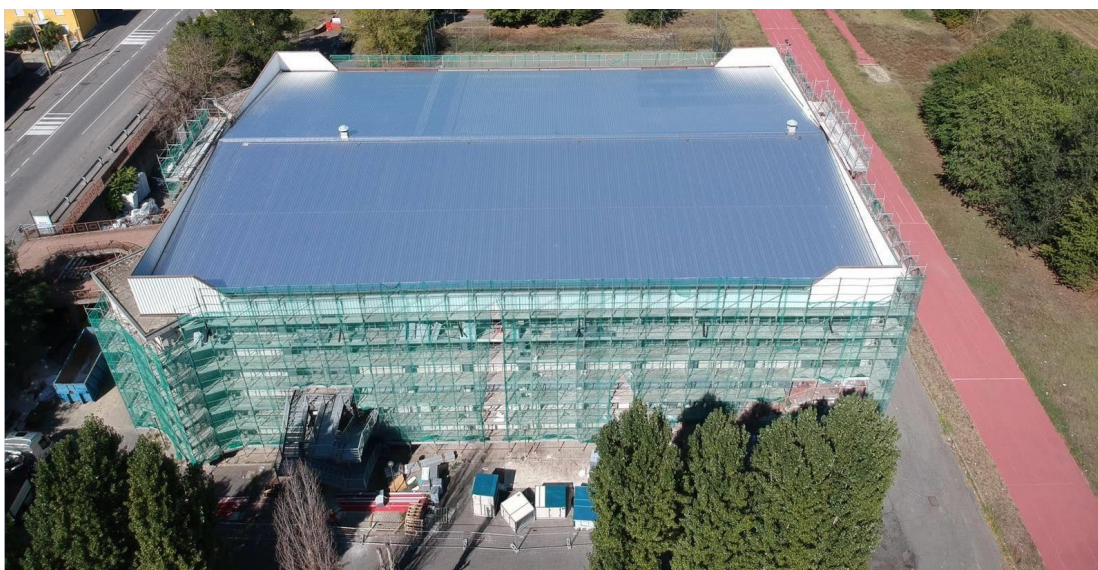
Foto n.1 – Manto di copertura
