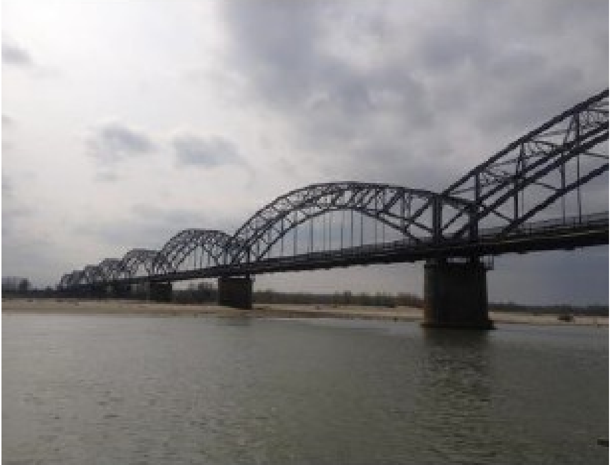
Foto n° 1 Ponte della Gerola (PV)
