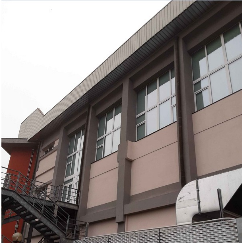
Foto n.2 – Interventi di realizzazione cappotto esterno
