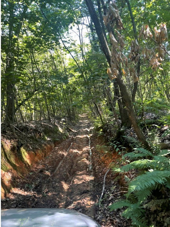
Foto 3 – Profondi solchi da erosione concentrata delle acque dilavanti superficiali. Pista in trincea.
