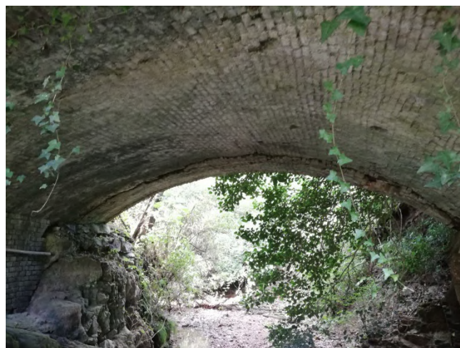
Foto 8 – Particolare dell'intradosso del Ponte sul Torrente Strona.
