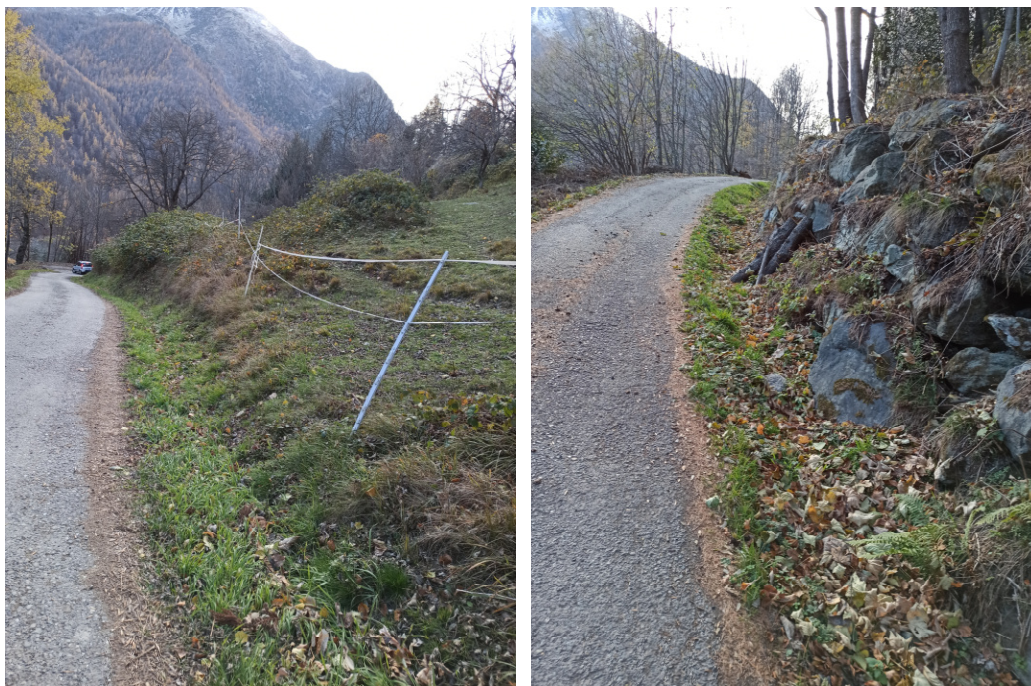
Tratto di intervento su Strada Pian del Tetto – La Comba
