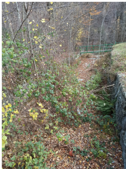
Tratto di intervento su Rio del Ra
