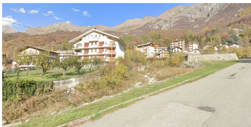
Tratto di intervento su Rio della Chiesa
