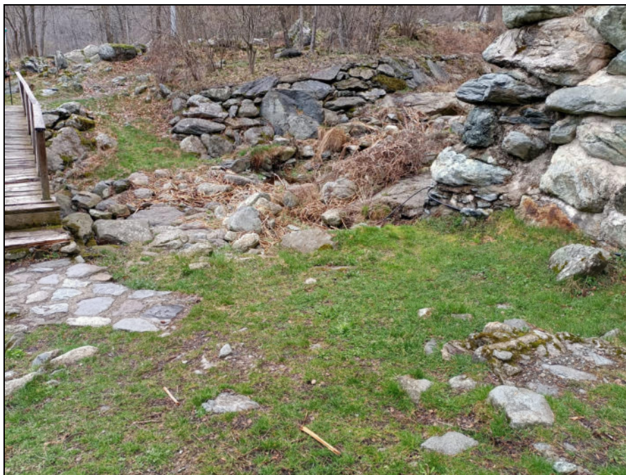
Foto 1: vista del guado, da est verso ovest. Si intravedono la passerella in legno, a valle, ed i due muri di sponda posti a monte.
