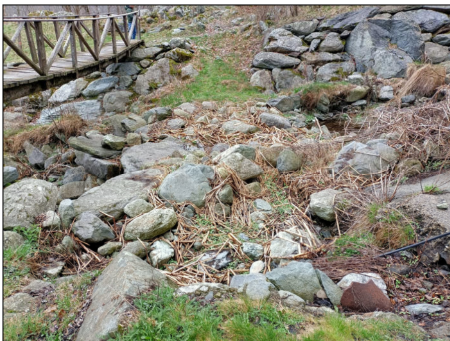
Foto 2: dettaglio del guado esistente.
