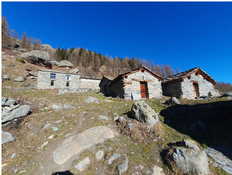
Fig. 3: Vista alpeggio da Sud-Ovest
