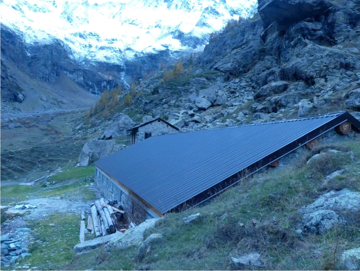
FOTO 2 - Vista stalla da Est
