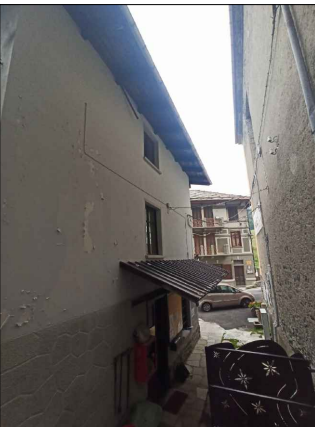
Prospetto ovest - Dettaglio
