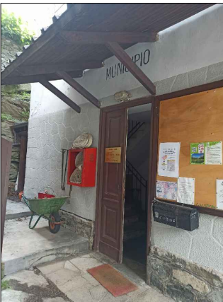
Prospetto ovest - Dettaglio
