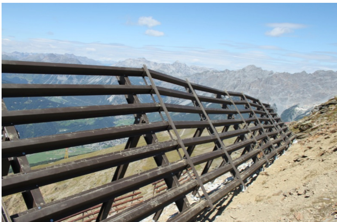
Esempio ponti da neve in acciaio installate in area di distacco
