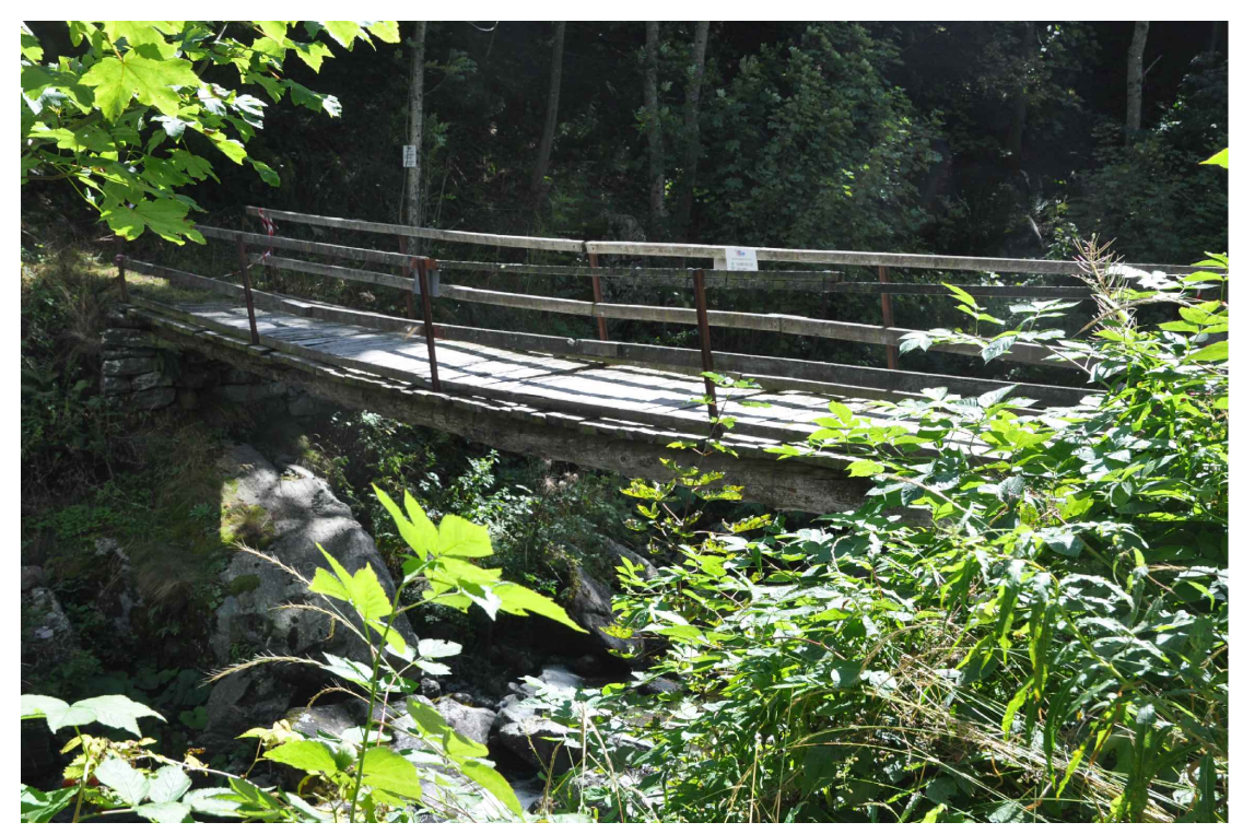
FOTO DELLA PASSERELLA OGGETTO DI INTERVENTO
