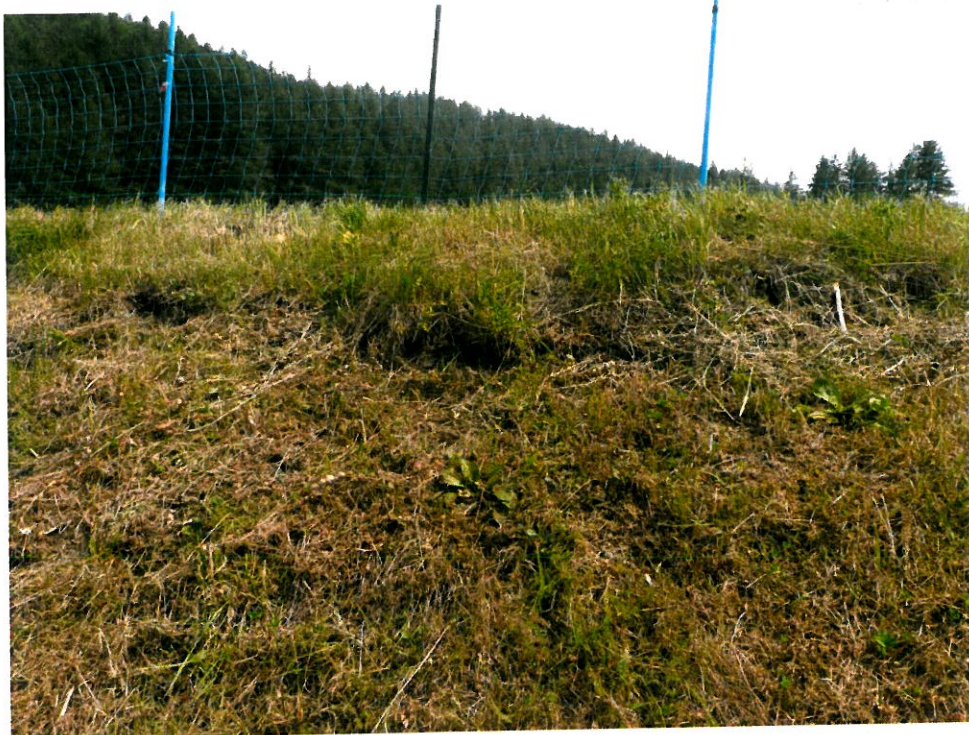
Bacino Italsider settore sotto il coronamento lato ovest il 17/07/2015
