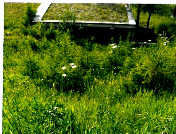
Il paramento di valle giugno 2015 da monte
