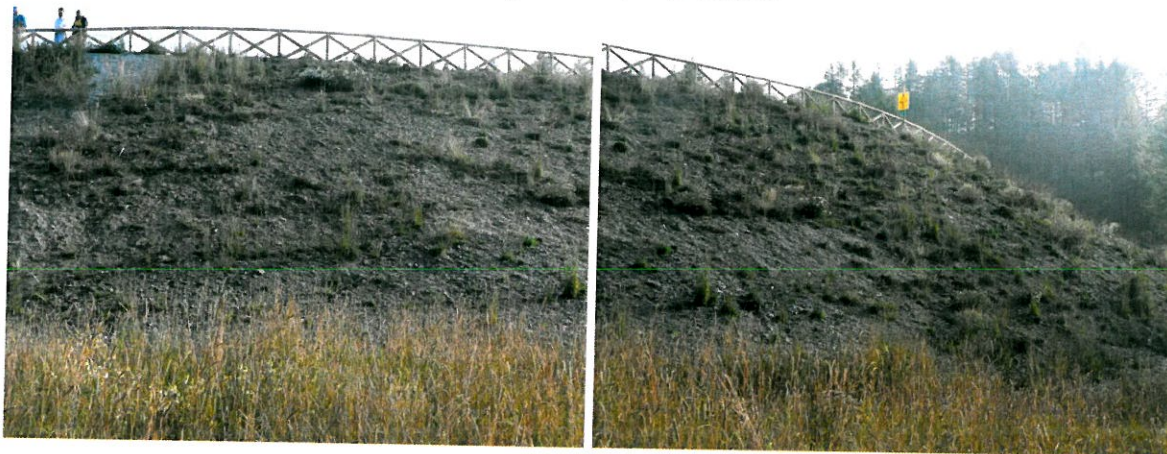
Il paramento di valle nel settembre 2006
