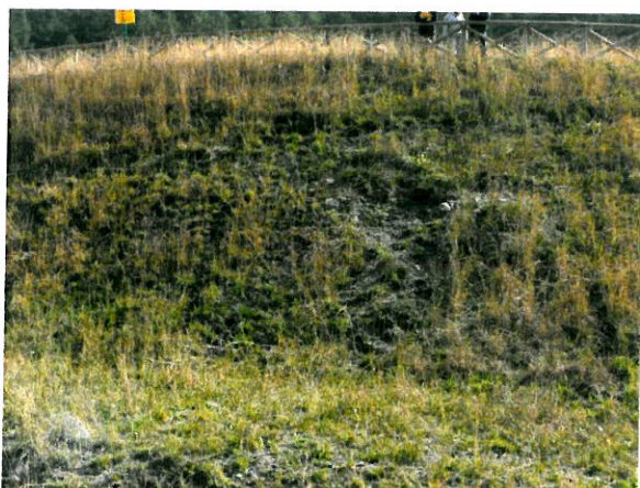
Il paramento di valle settembre 2006 da valle
