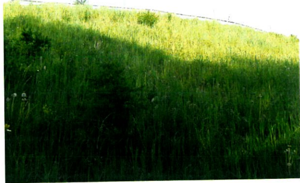
Il paramento di valle giugno 2015
