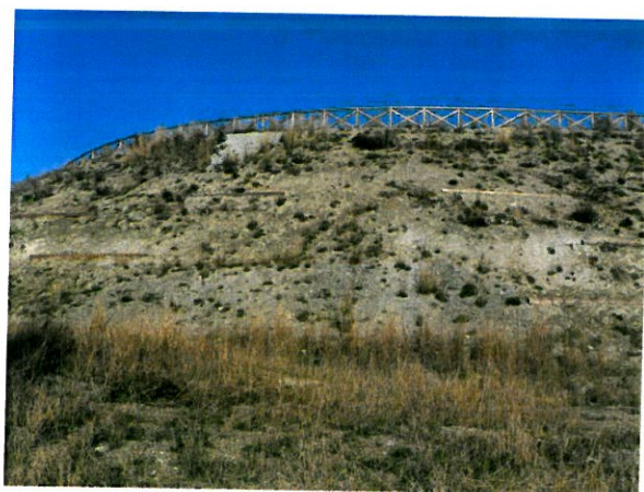
Il paramento di valle nel novembre 2006
