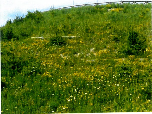
Il paramento di valle giugno 2015
