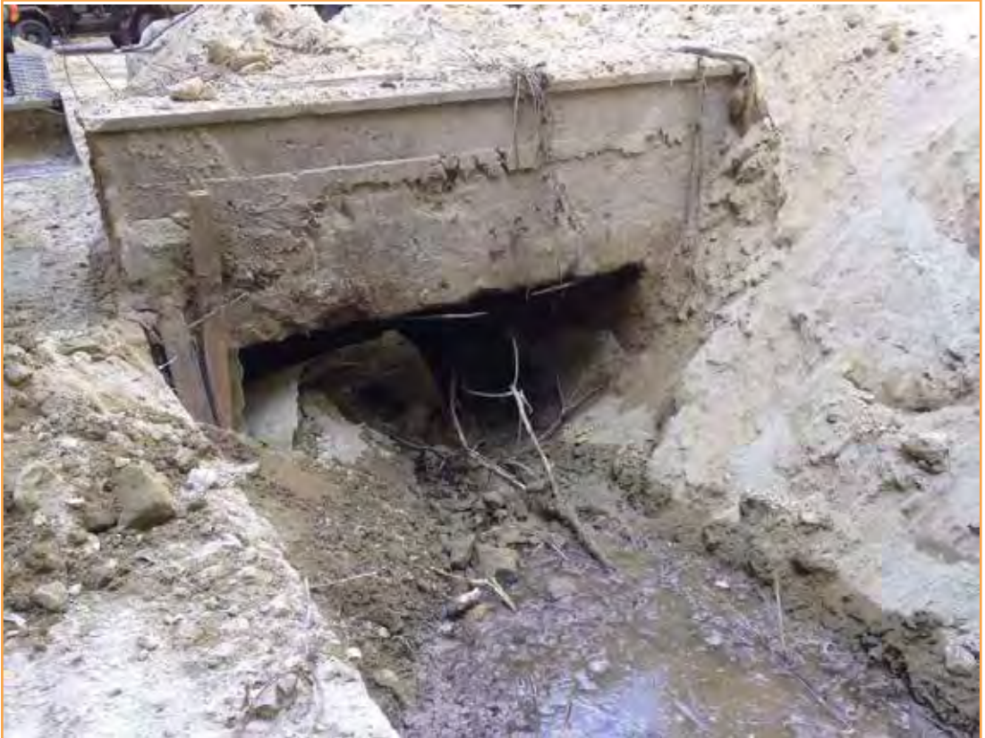
Figura 15.6: Scatolare in calcestruzzo parzialmente ostruito dalla frana verificatasi lungo la scarpata del vallone Senigallia
